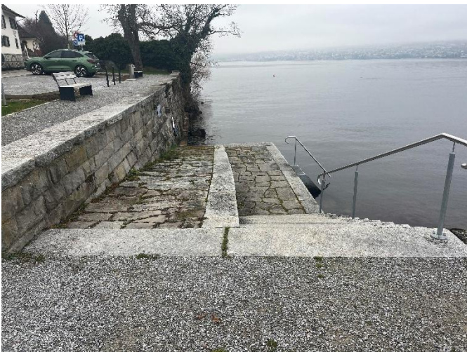
Treppe kleiner Parkplatz
